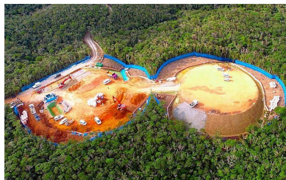
ヘリパッド建設工事が進む米軍北部訓練場内N1地区 写真 11/13 沖縄タイムス
