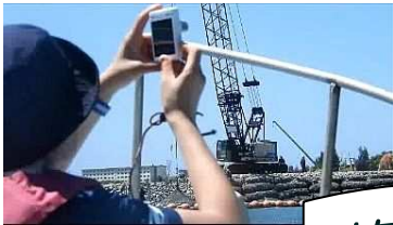
船で工事が行われている K9 護岸のすぐそばまで 行きました
