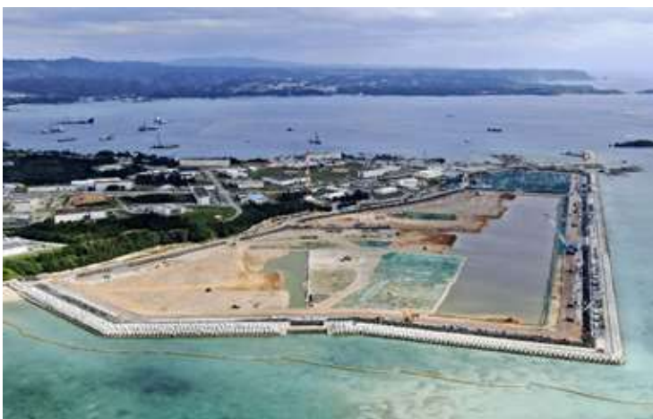
朝日新聞 シュワブ沿岸で進む土砂埋め立て工事 2020年12月、沖縄県名護市辺野古 (小型無人機から)
