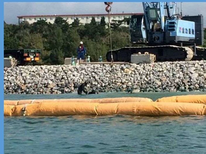
辺野古の海草藻場を埋め立てる護岸工事
